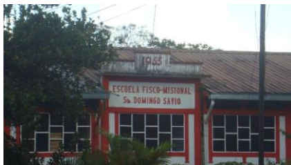
Ilustración 27: Infraestructura de la Escuela Fisco-Misional Domingo Savio;
