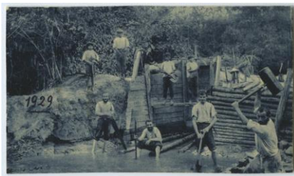
Ilustración 29: Construcción del canal de Tena para generación de energía eléctrica, año 1929;
