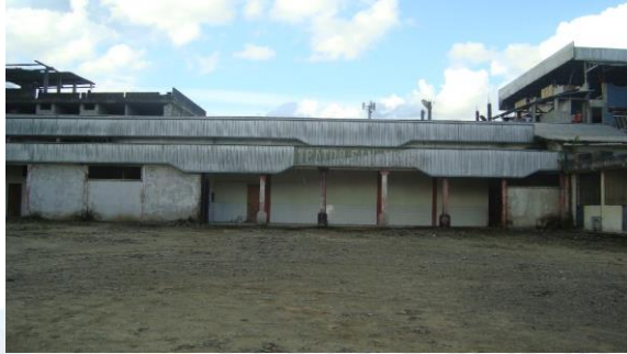
Ilustración 26: Edificación del Teatro San José;
